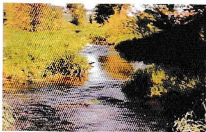
◆近自然化後16年を経たスイス・チューリッヒ州ネフパッハ川。1983年施工（資料：クリスティアン・ゲルディー氏） いわゆる「春の小川」が人工的にしかも安く実現できる。その場にある材料を再利用し、できあがりの形は川の流れや自然の植物の成長に任せたため、ほとんどお金がかかっていない。
